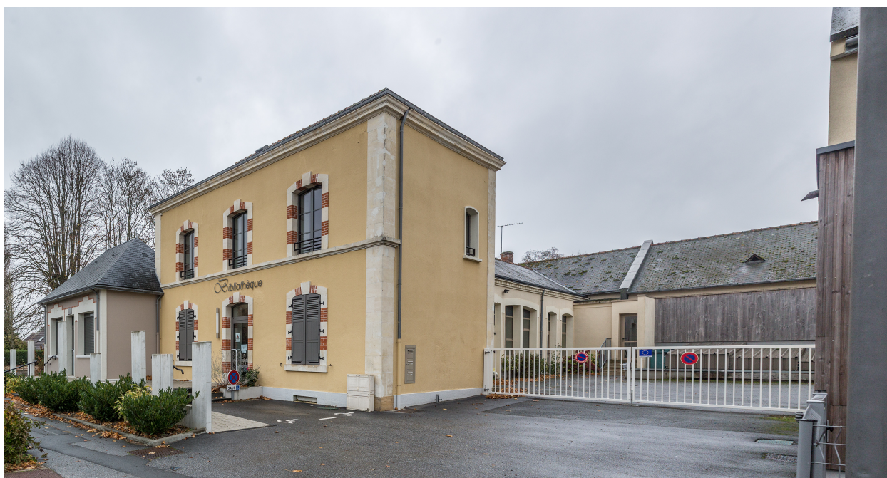
Une vue d'ensemble de l'école.
