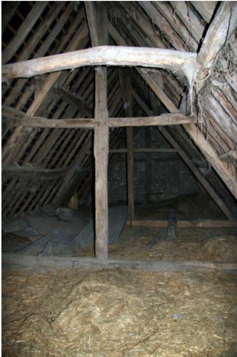
La grange : ferme de charpente.
