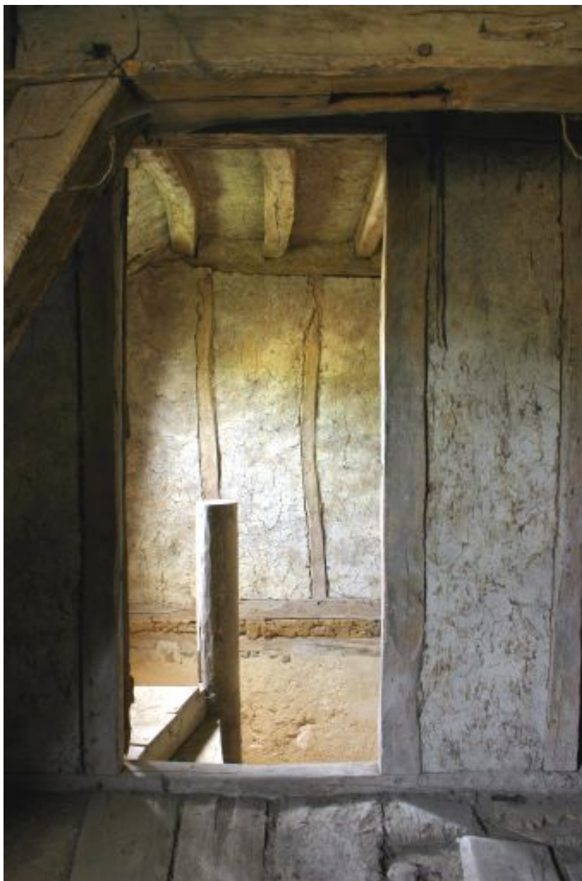
Cage d'escalier en pan-de-bois dans œuvre : le palier du comble.
