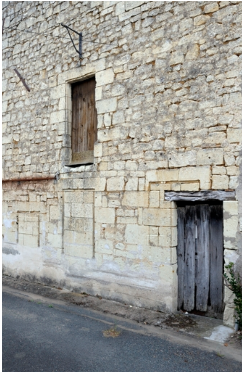
Hôpital, aile est. Détail des remaniements de maçonneries, avec obturation et reprise des baies.
