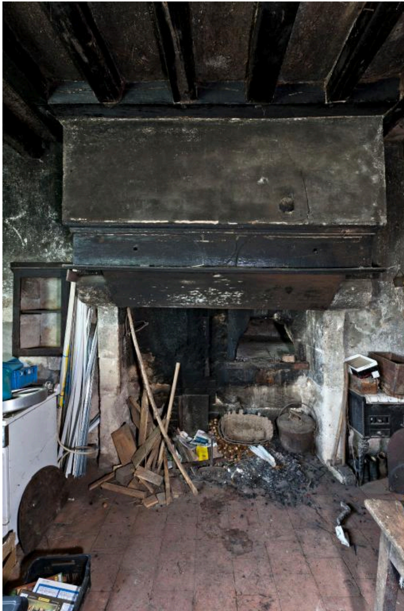
Maison, chambre à feu ouest : cheminée au mur-pignon.
