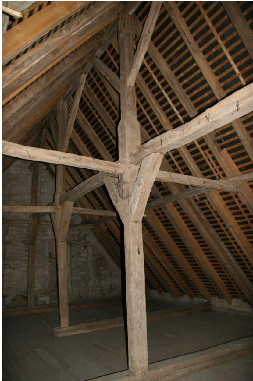
Le logis, aile du XVIe siècle : charpente
