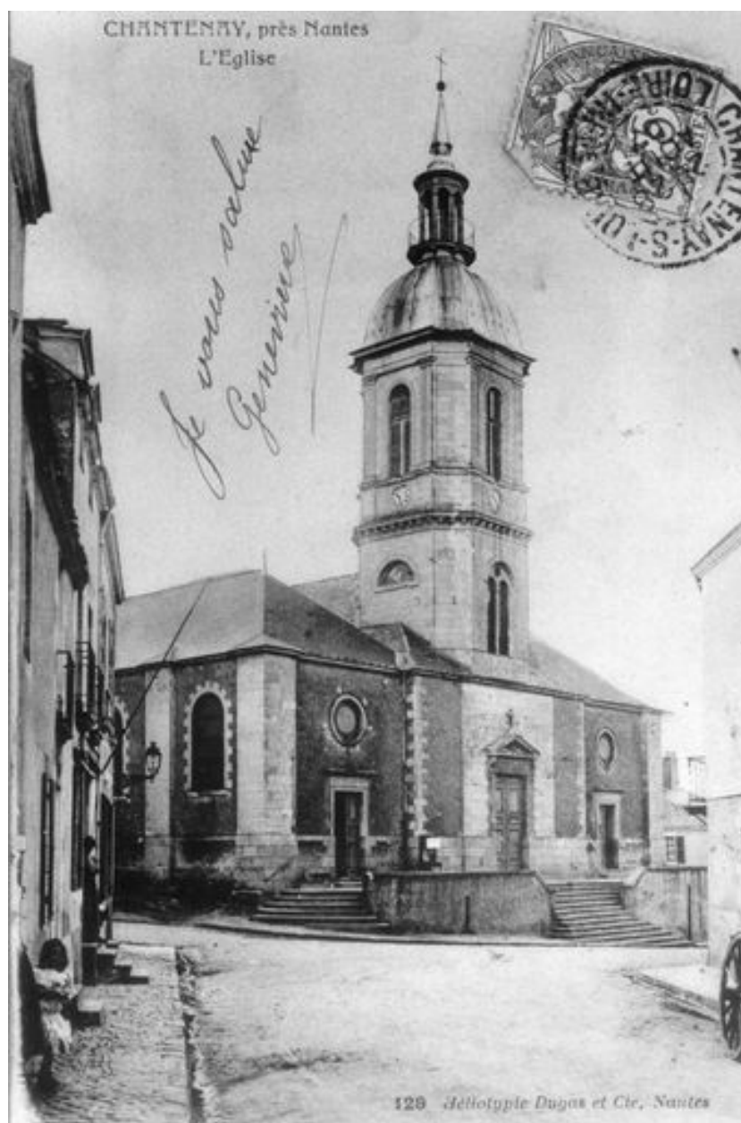
Eglise Saint-Martin, vue de la rue de Tréméac, début du XXe siècle.
