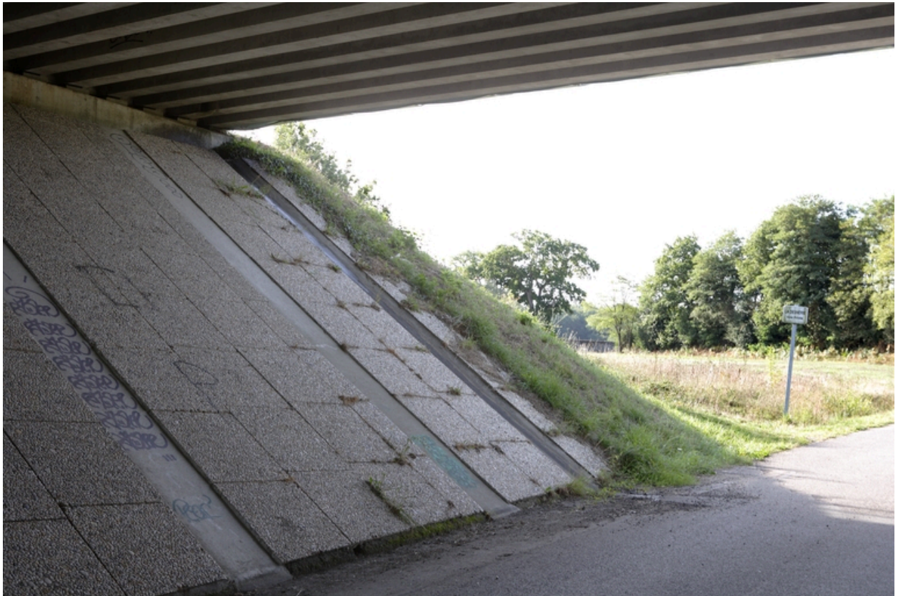
Pile d'extrémité sur talus.
