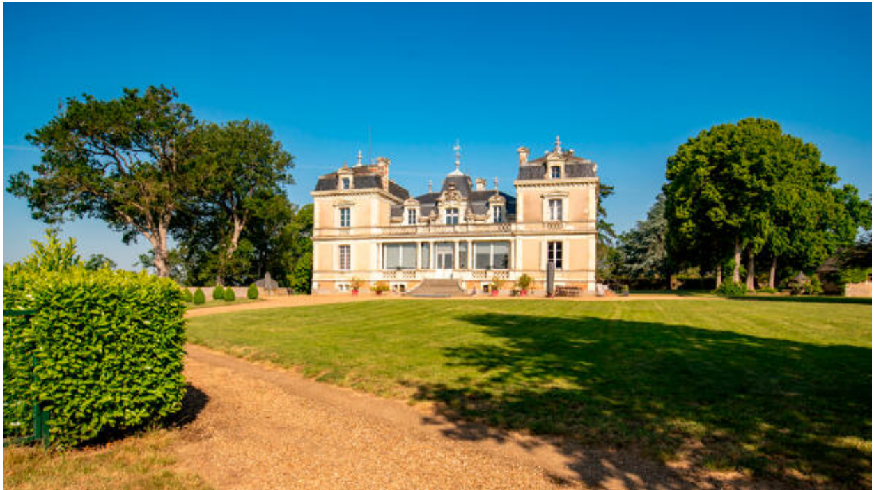
L'élévation antérieure, côté sud-est.
