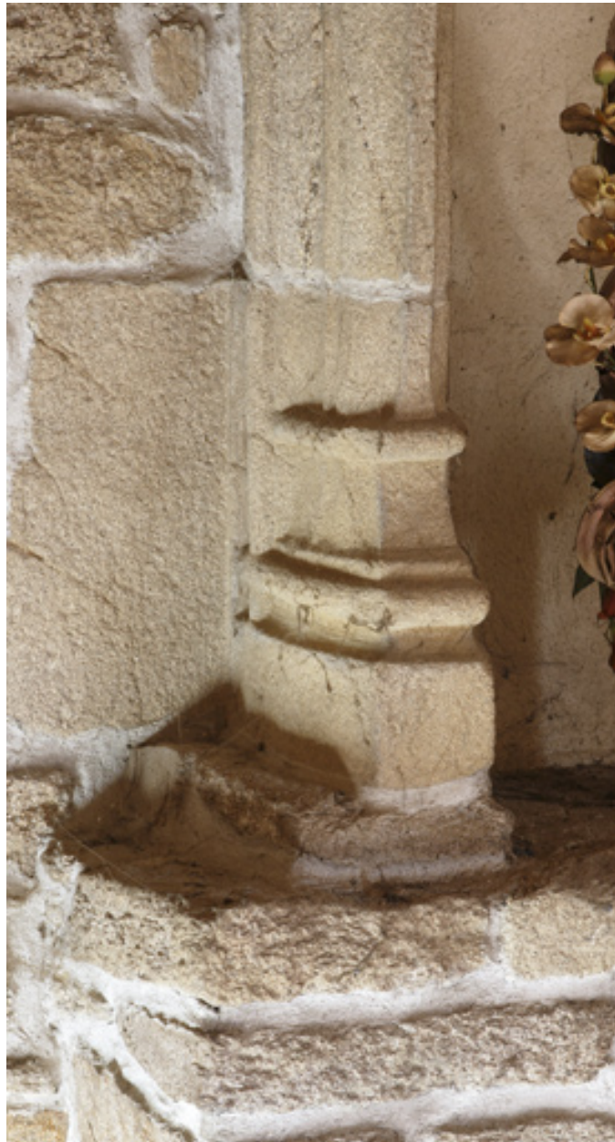
Logis. Cheminée de l'étage. Détail de la base du piédroit de gauche.
