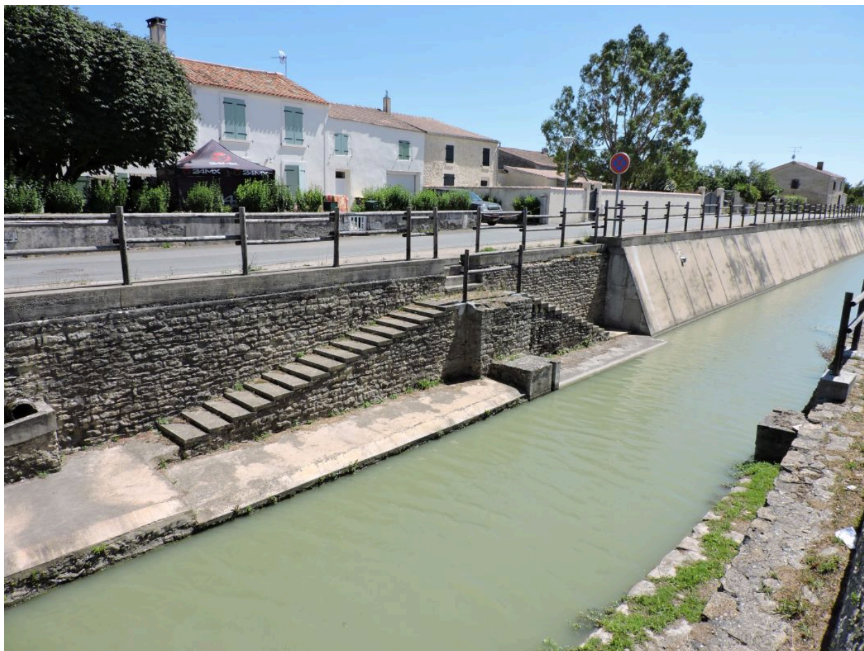
L'ancien lavoir en aval du pont.
