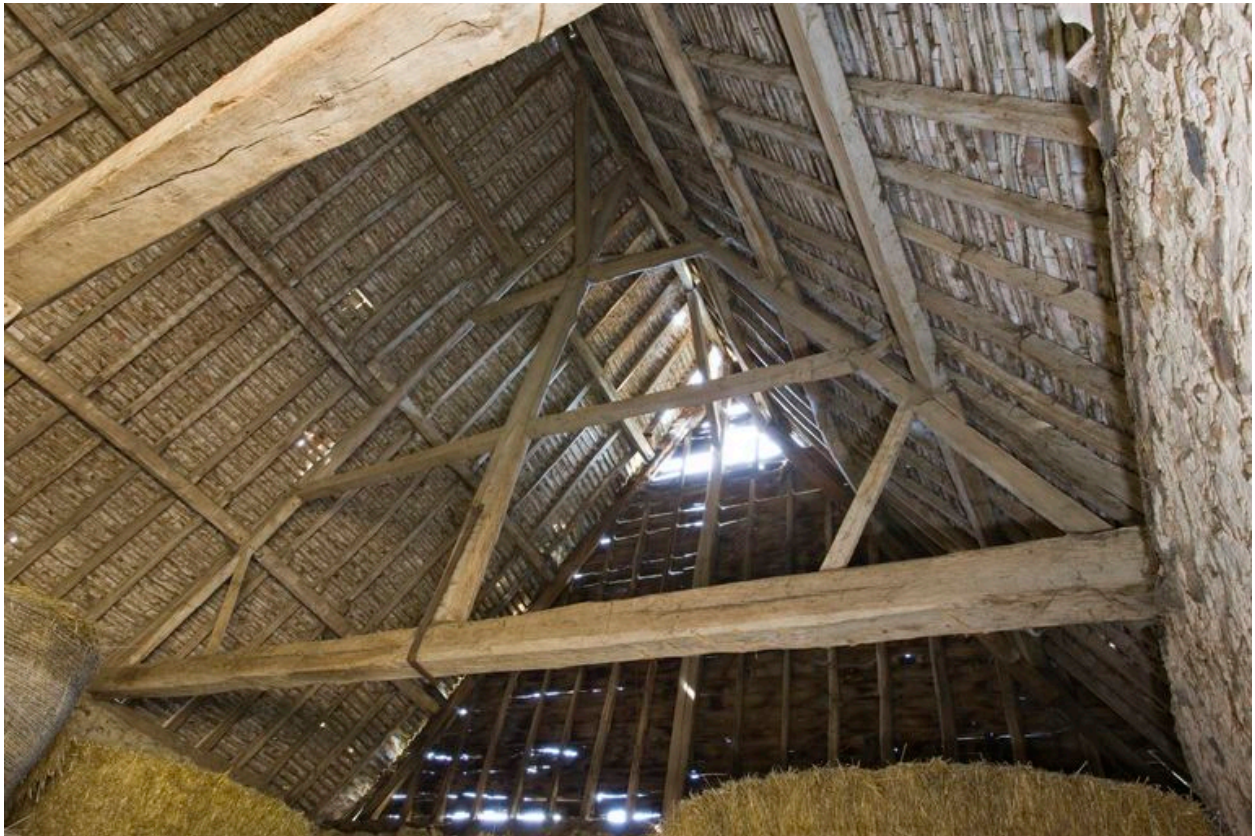
Ferme de charpente droite de la grange-étable.
