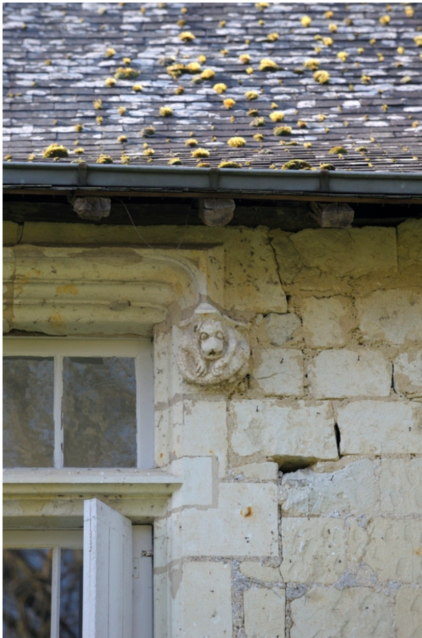
Logis. Manoir médiéval. Façade nord, larmier de la fenêtre haute (ouest), détail du culot sculpté (droit), probablement un écureuil.
