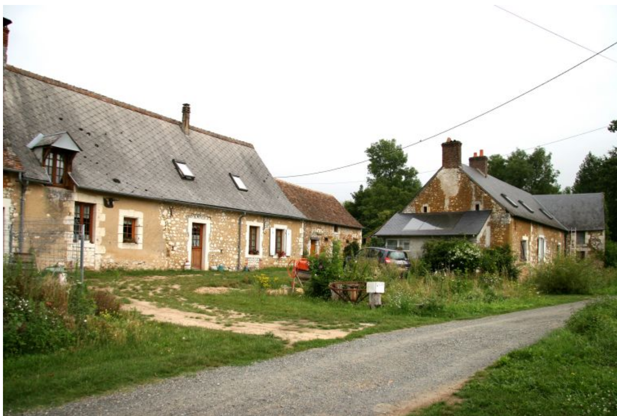
Vue d'ensemble de l'ancienne maison seigneuriale et du moulin.
