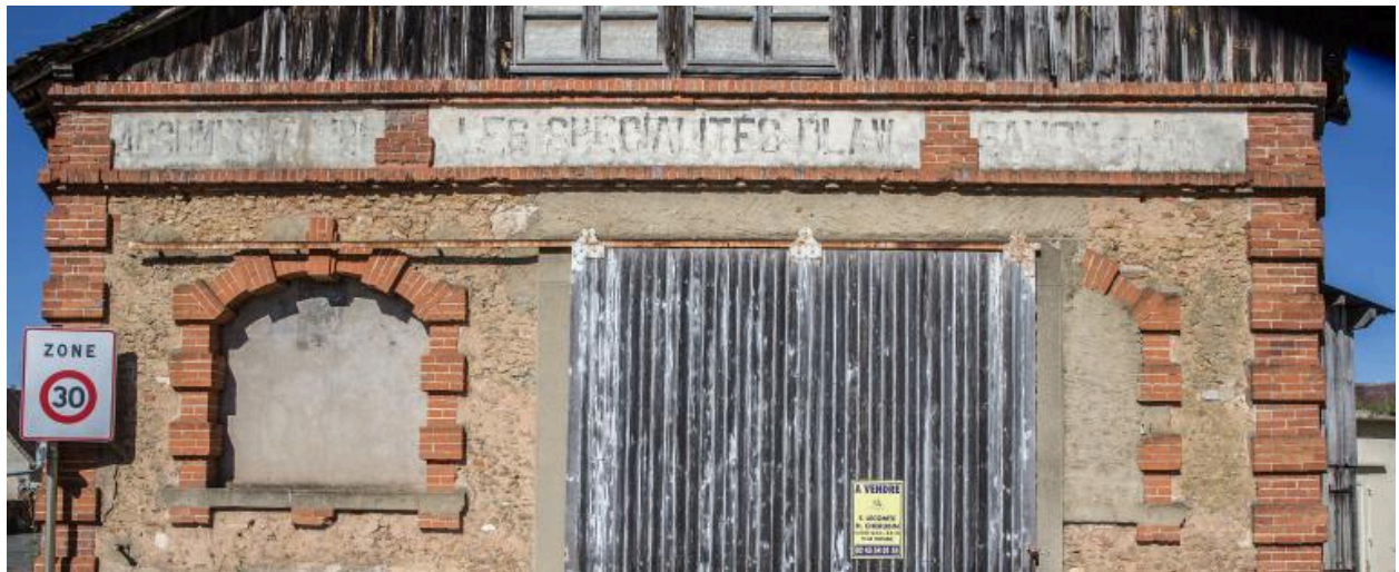
L'enseigne peinte sur le pignon de l'ancienne usine.
