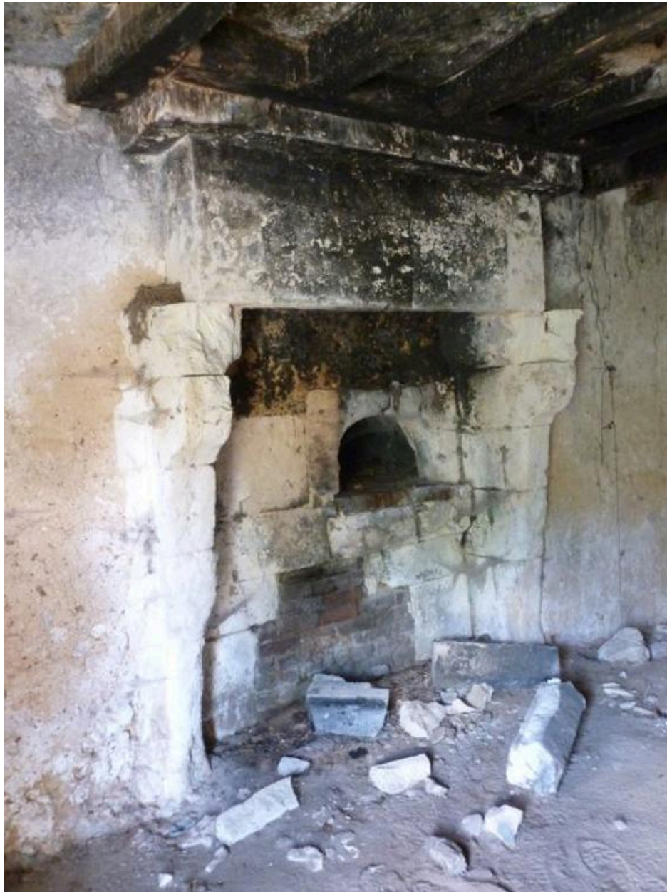
Ferme bloc à terre, maison : cheminée au mur ouest.
