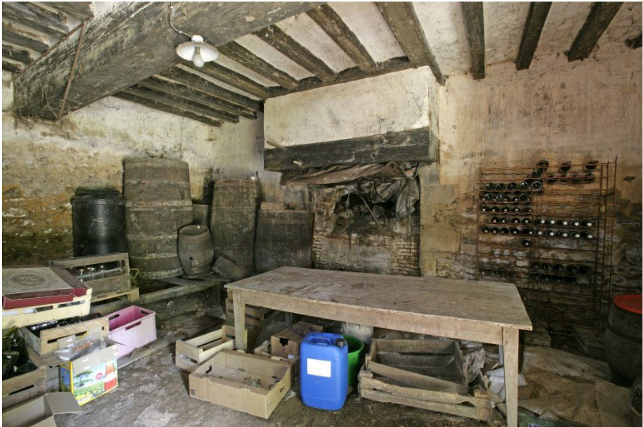
Fournil-remise : intérieur du fournil.
