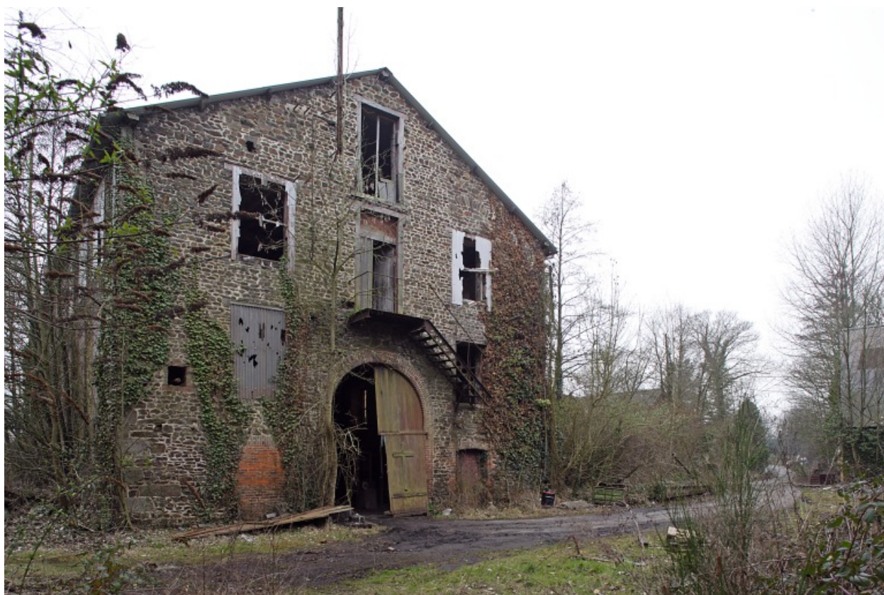
L'élévation nord de la filature.
