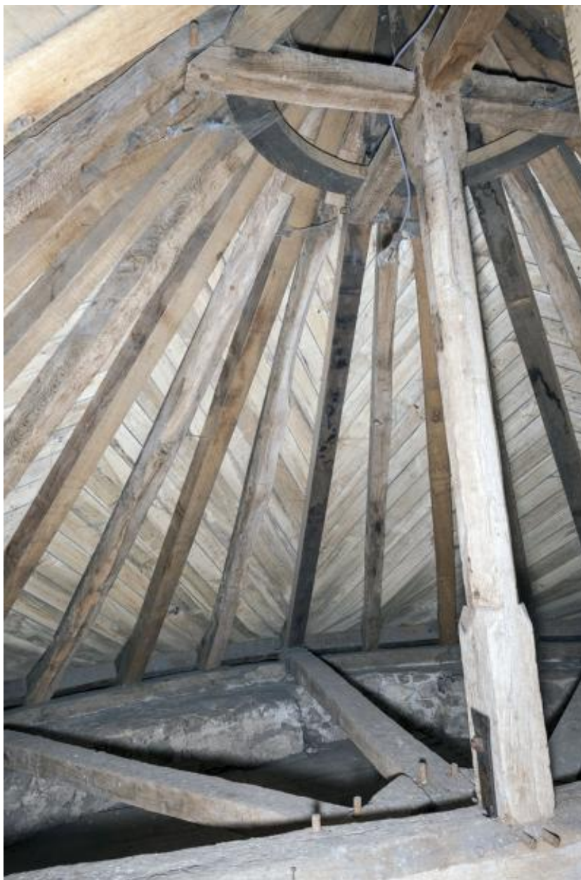
Charpente de la tour occidentale du châtelet.
