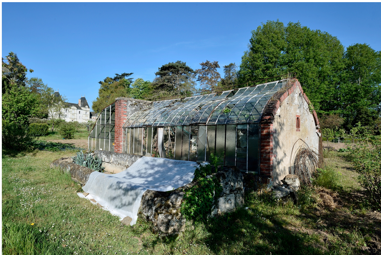
Vue extérieur de la serre.
