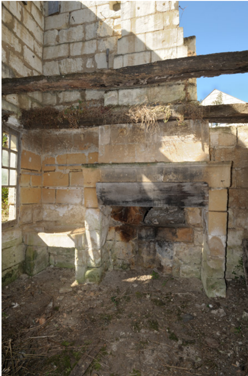
Appentis, ruiné. Rez-de-chaussée, cheminée (seconde moitié XVIIIe ou tout début XIXe siècle).
