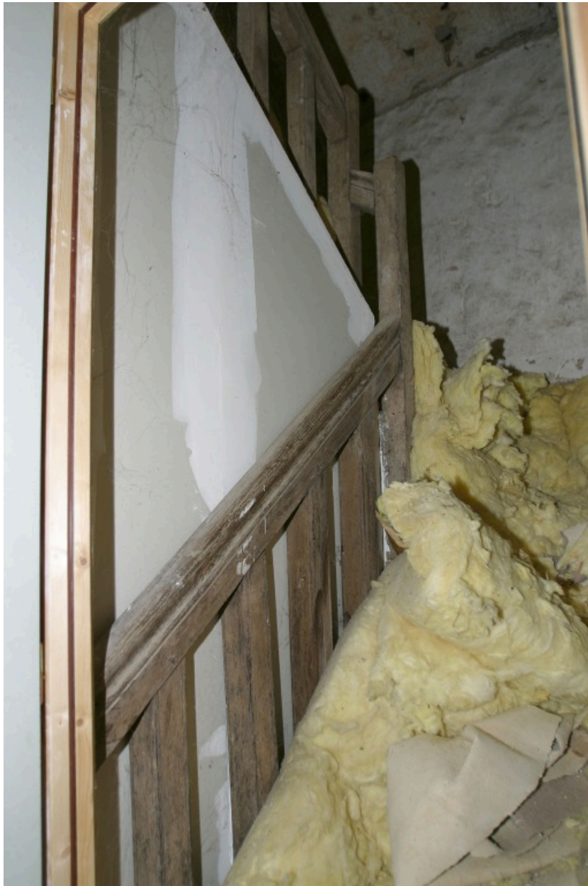
Première ferme, maison de maître : l'escalier d'accès au comble.
