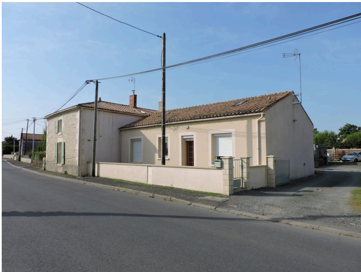
L'ancienne grange-étable, perpendiculaire à l'arrière du logis, vue depuis le nord.
