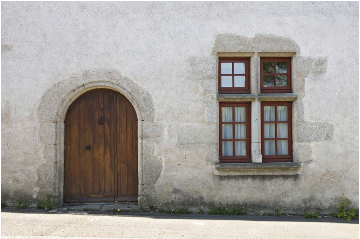
Elévation nord : porte cintrée chanfreinée et baie à meneaux, 15e siècle.
