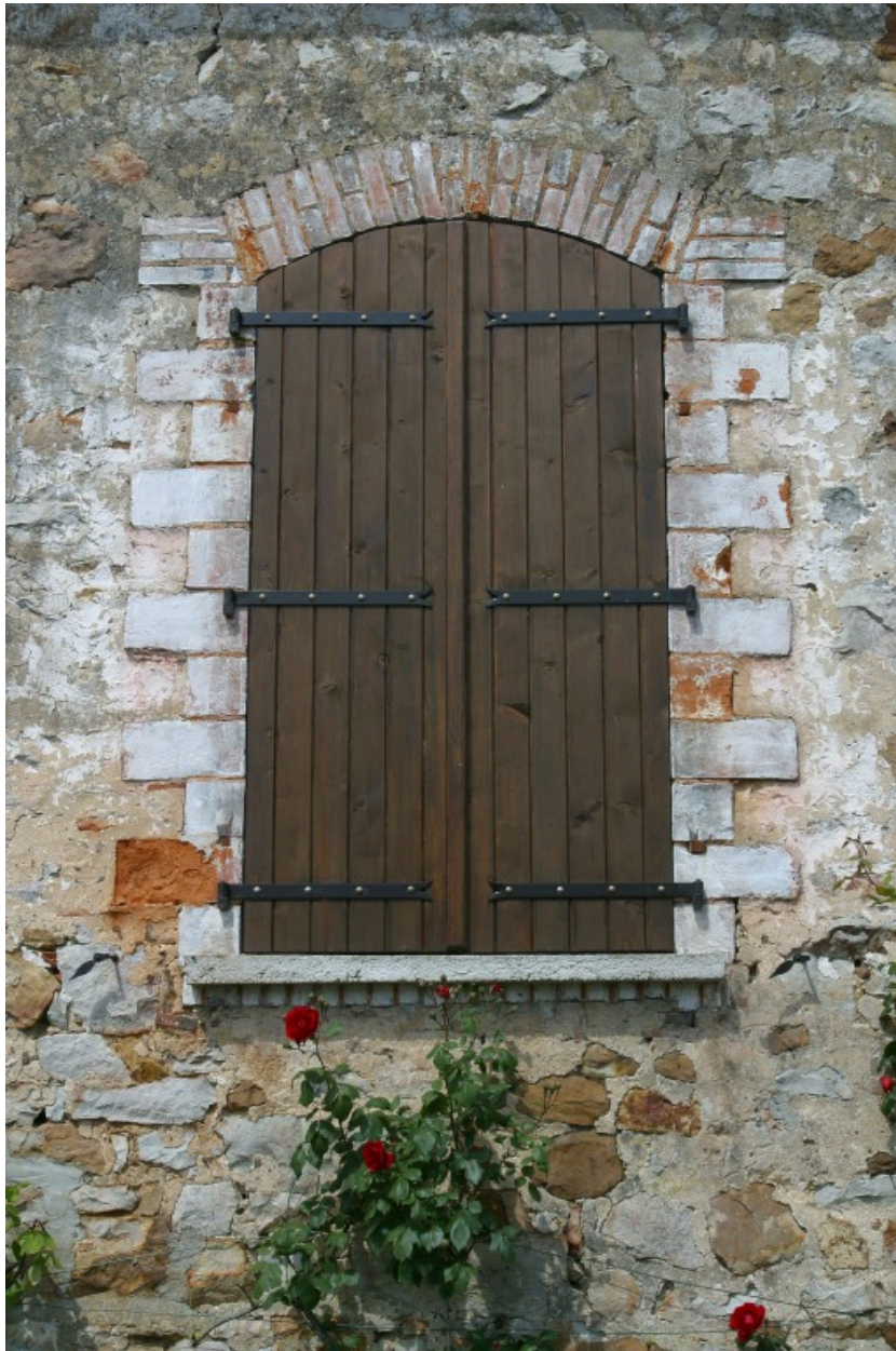
Détail de la façade du logis : fenêtre.
