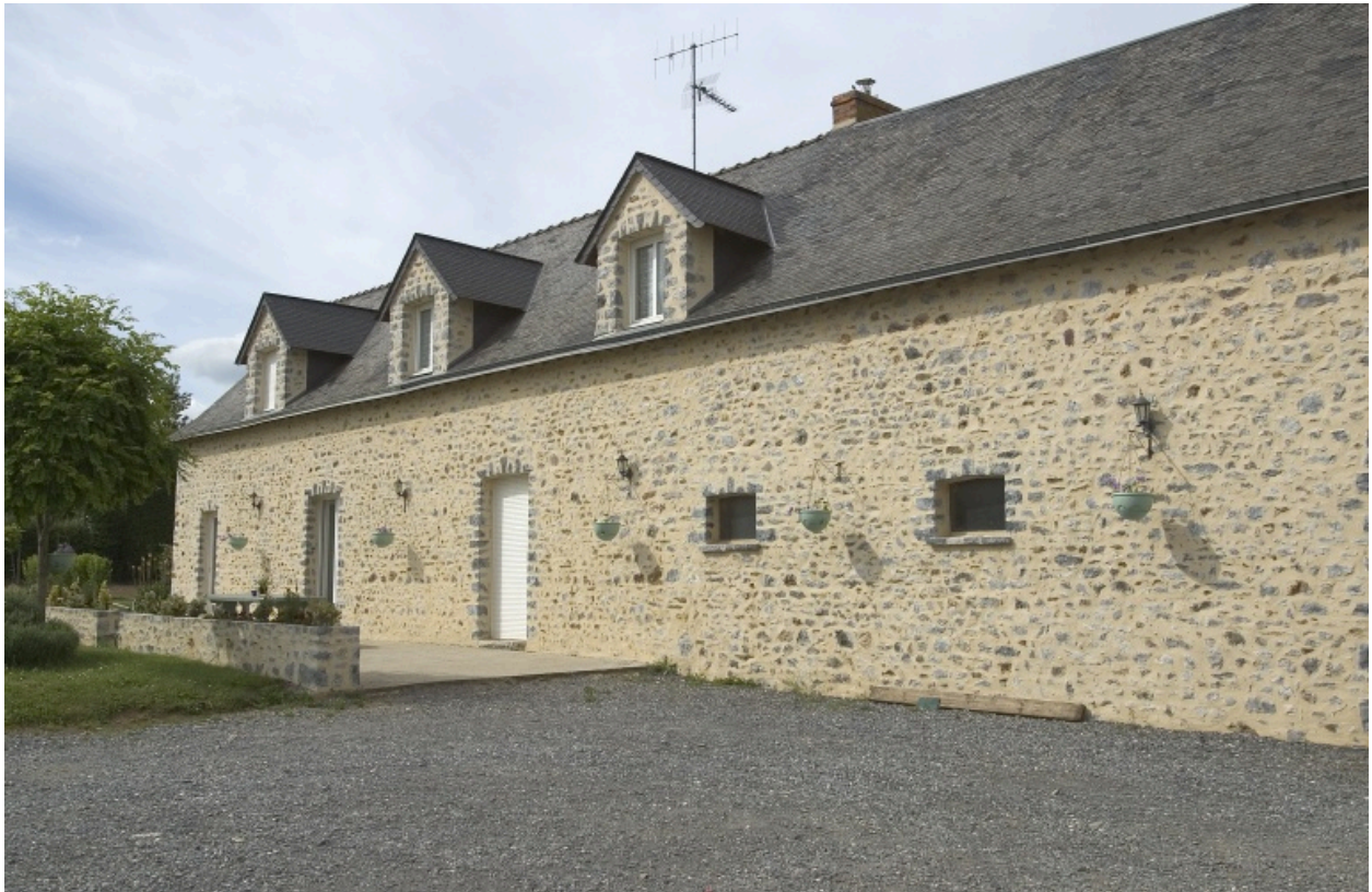
Le logis vu depuis le sud.
