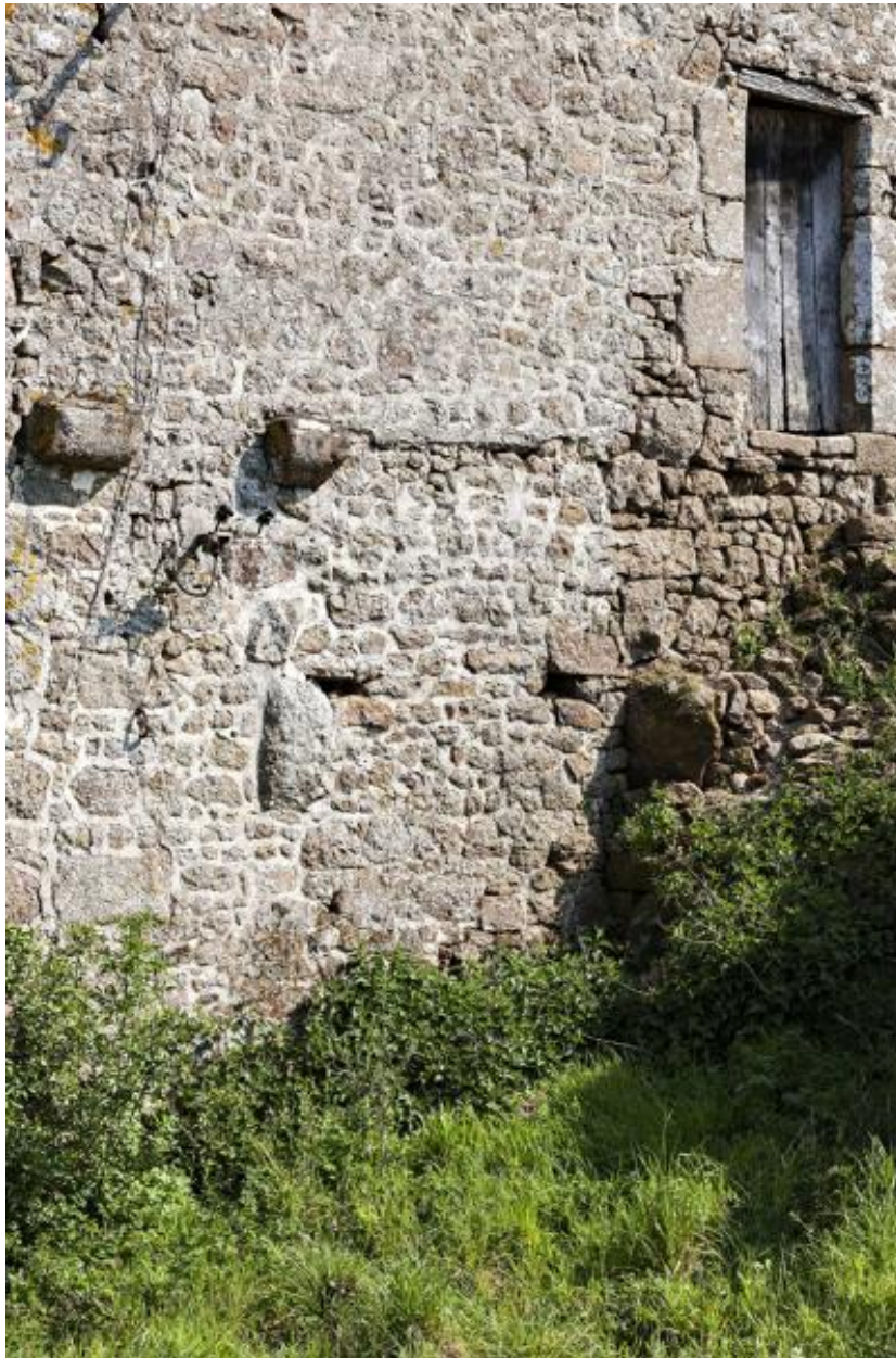
Mur-pignon sud du manoir.
