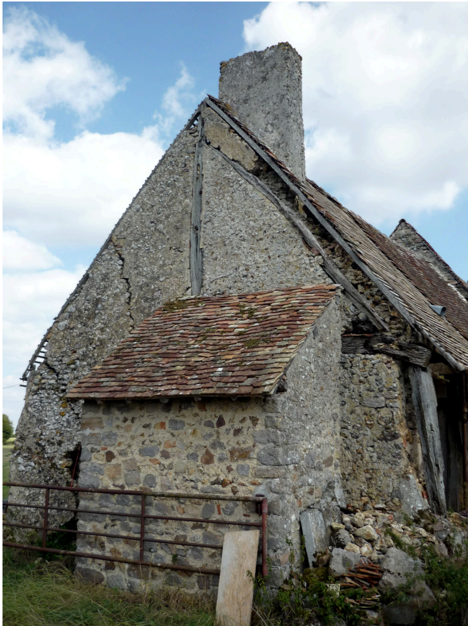
Mur-pignon ouest du logement ou fournil (Etat en 2003).
