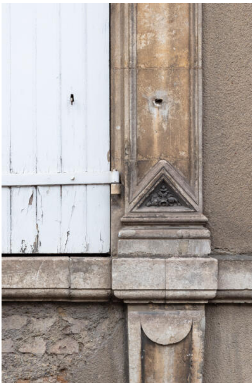
Vue de la partie inférieure du jambage d'une fenêtre au rez-de-chaussée.
