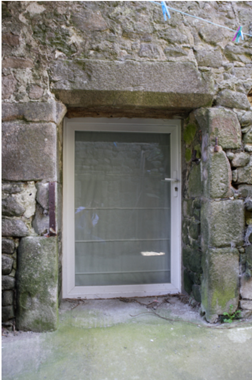
Logis. Façade nord. Partie ouest. Détail de la porte d'entrée.
