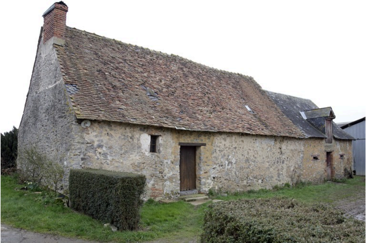
L'ancien logis-étable vu depuis la cour au nord.
