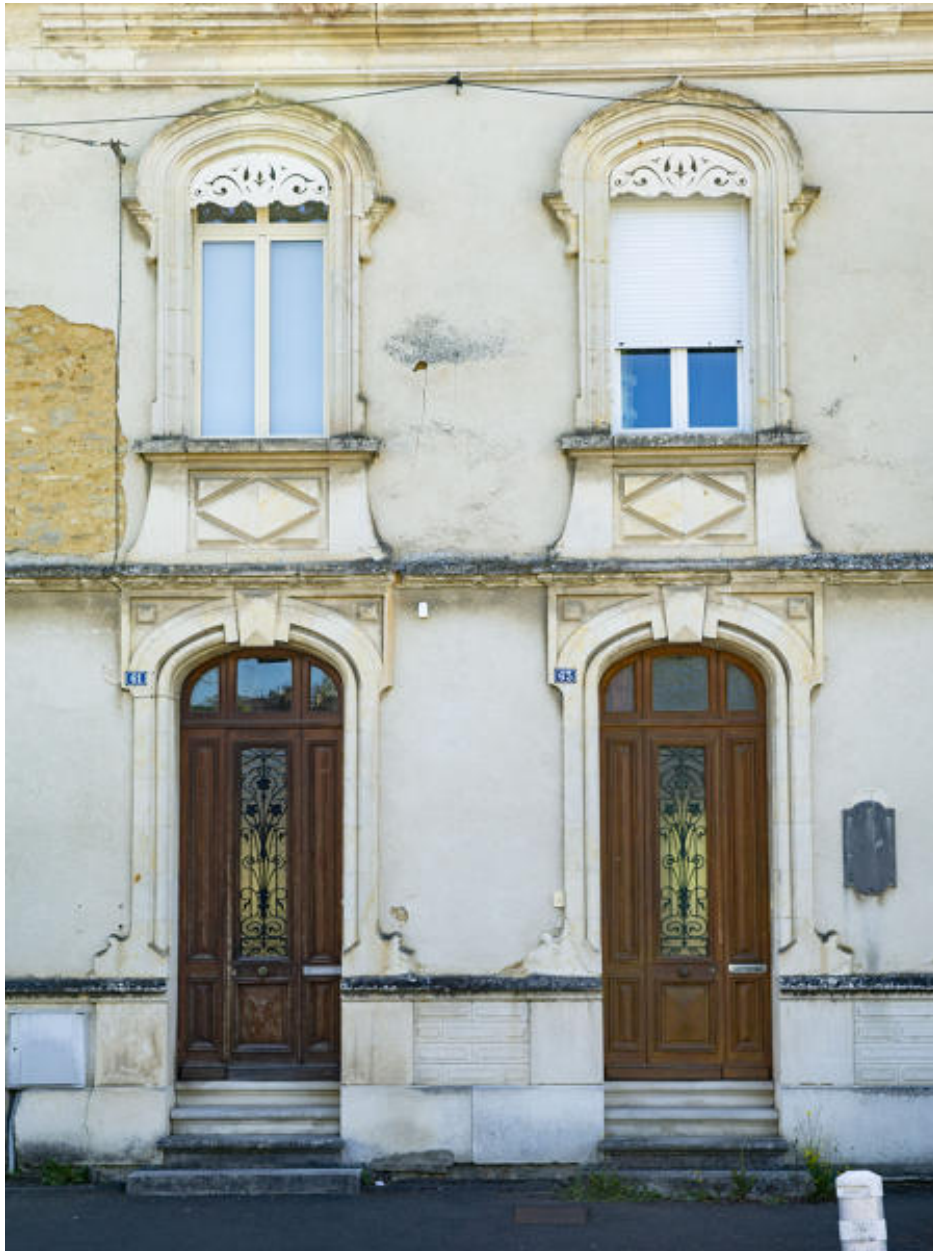
Un détail des travées centrales.
