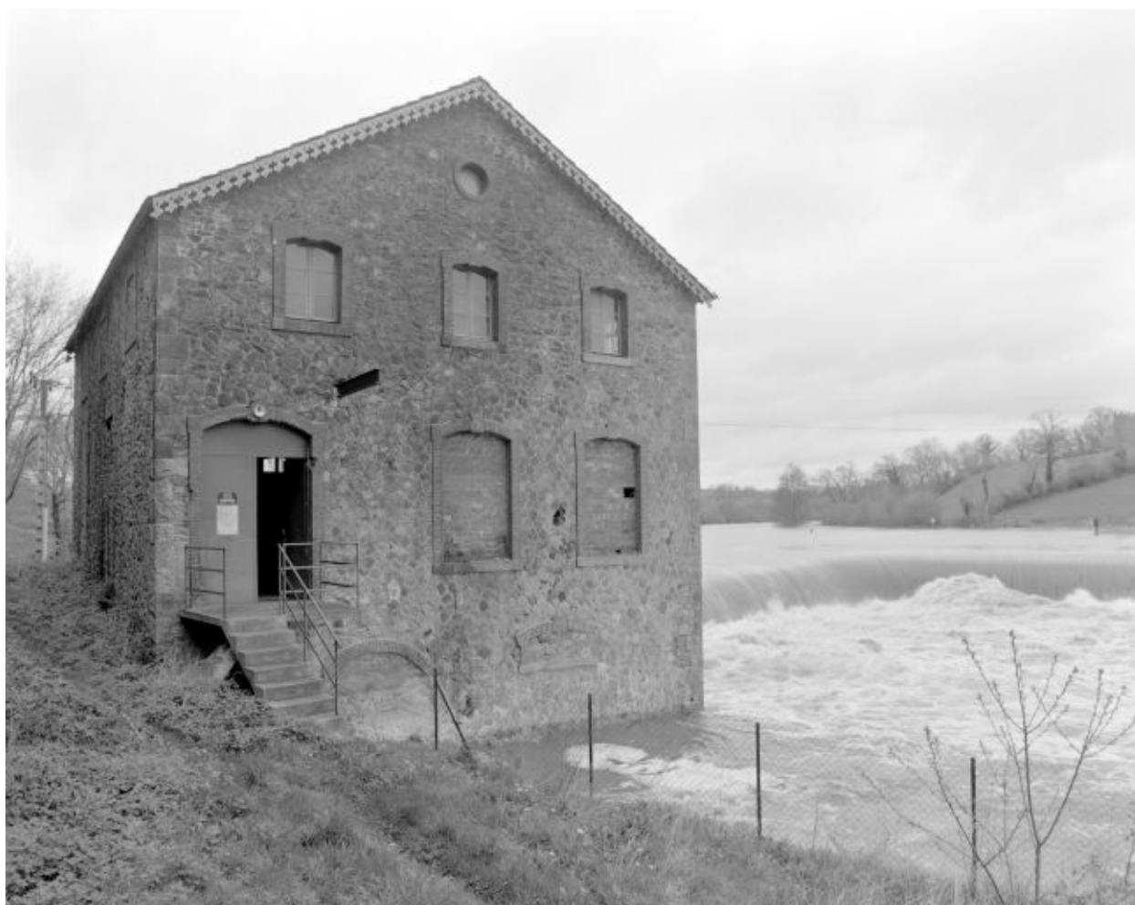
Façade sud (aval).
