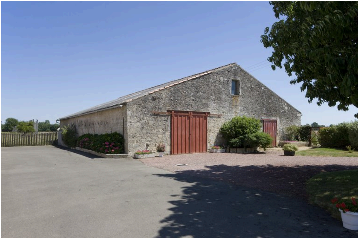
Etable-grange déplacée de la Petite Roulière et agrandie.
