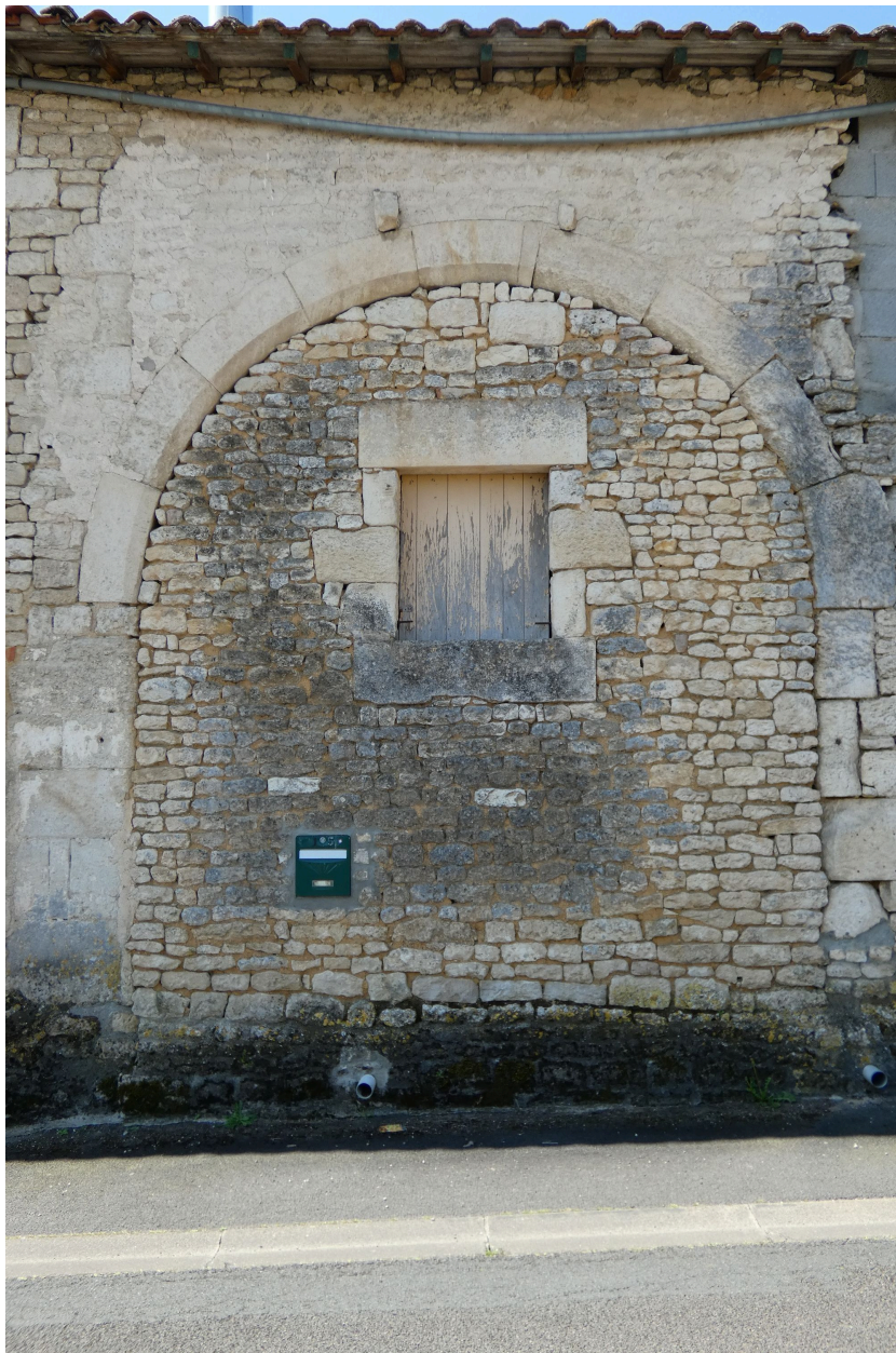
La porte de l'ancien passage d'entrée, murée.
