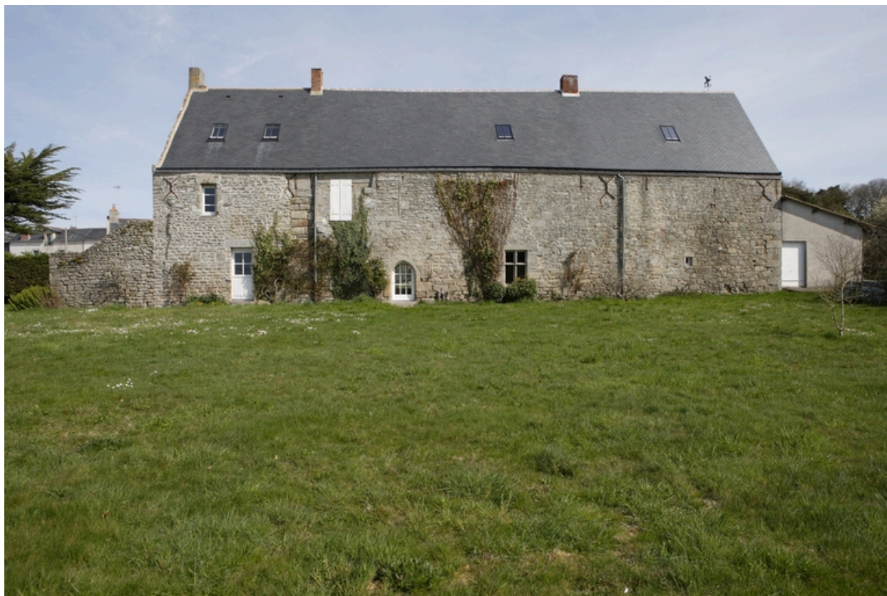
Vue de la façade sud.
