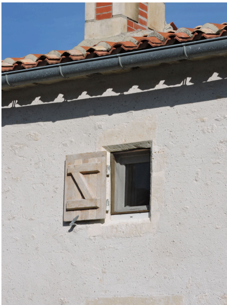
La petite baie à encadrement chanfreiné.
