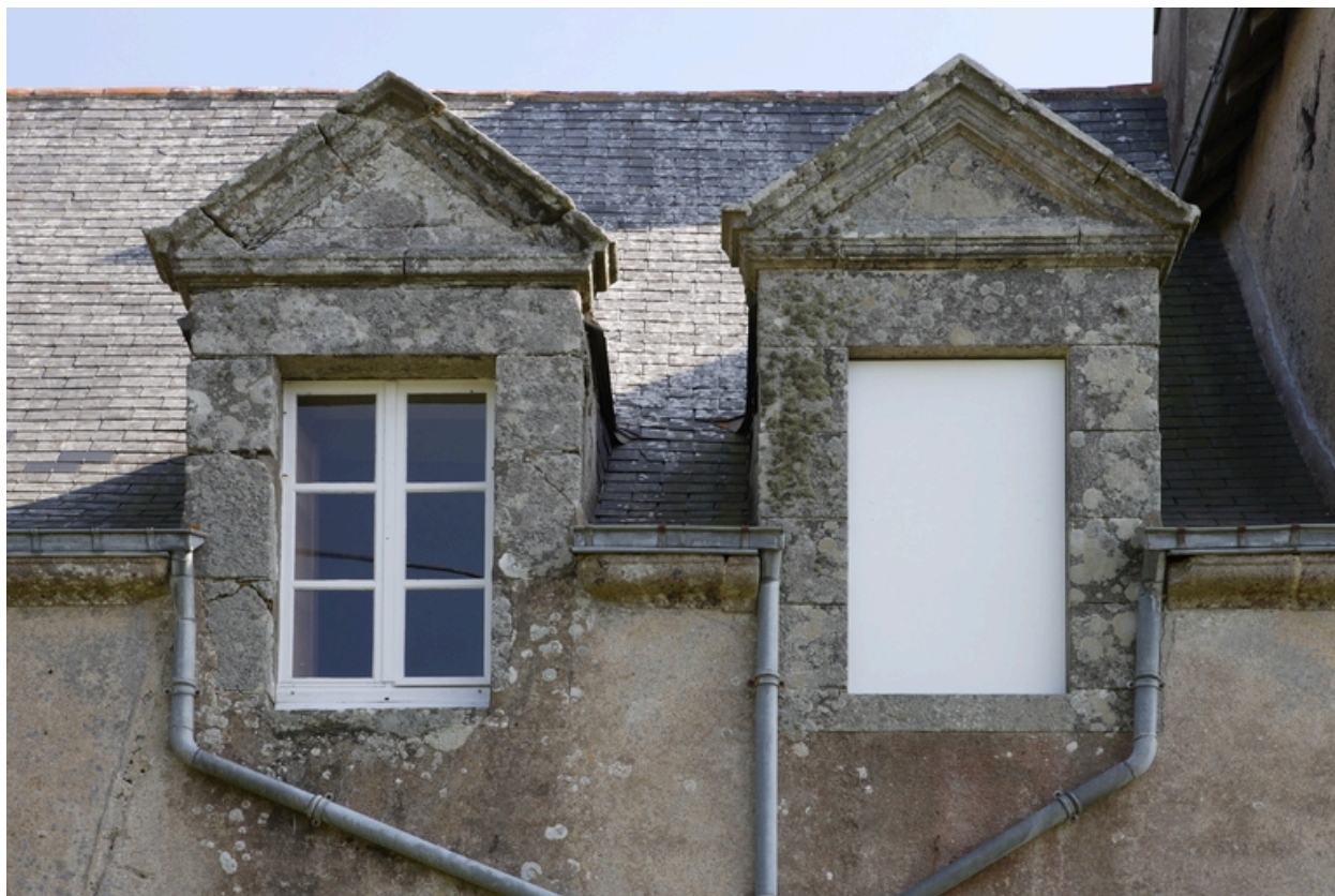
Logis. Façade ouest. Lucarnes (à droite).
