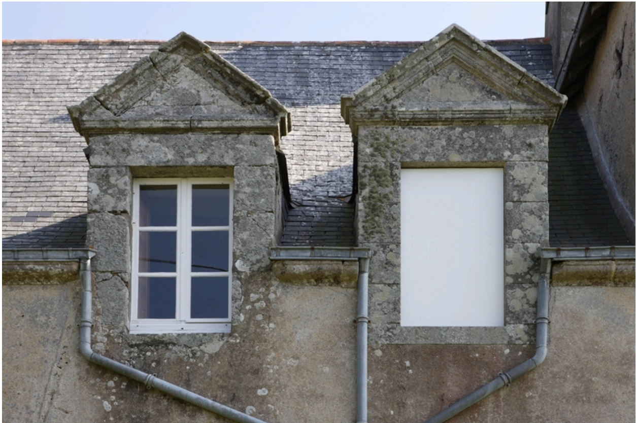
Logis. Façade ouest. Lucarnes (à droite).
