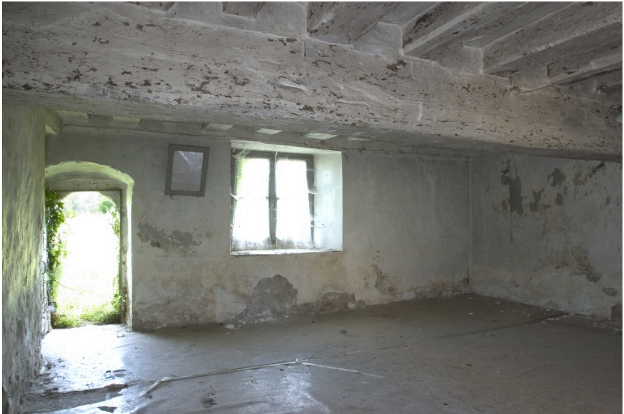
Intérieur du corps nord, rez-de-chaussée : la grande pièce vue depuis le sud.
