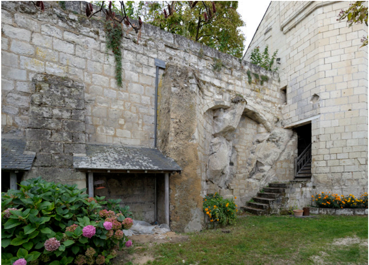
Mur de soutènement de l'ancienne basse-cour du château, en terrasse, avec confortements.
