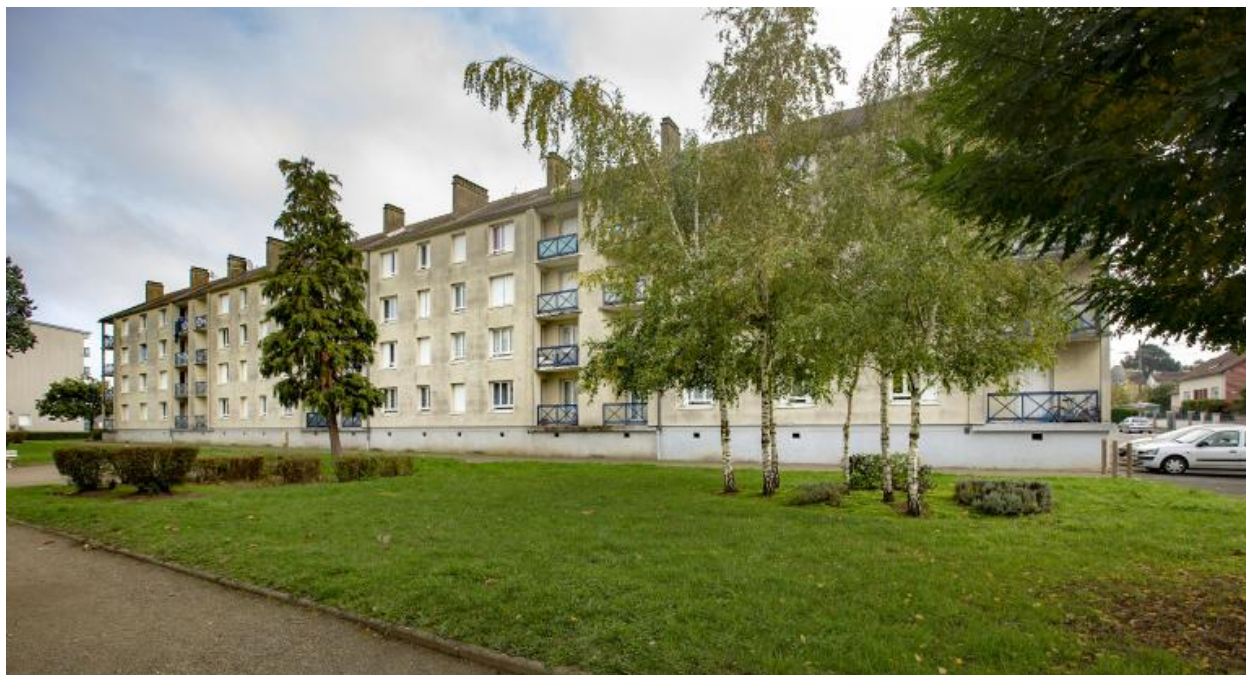
Vue d'une barre de la première tranche.
