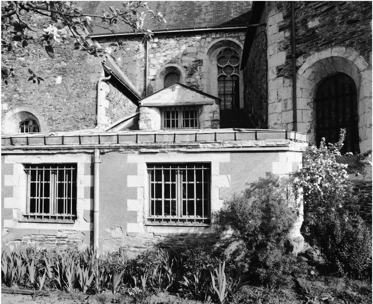
Eglise, élévation gauche : vue sur les baies éclairant la dernière travée de la nef et le chœur des religieuses entre la grande sacristie à gauche et la chapelle de Guéméné à droite ; au centre la petite sacristie et une galerie de passage au 1er plan.
