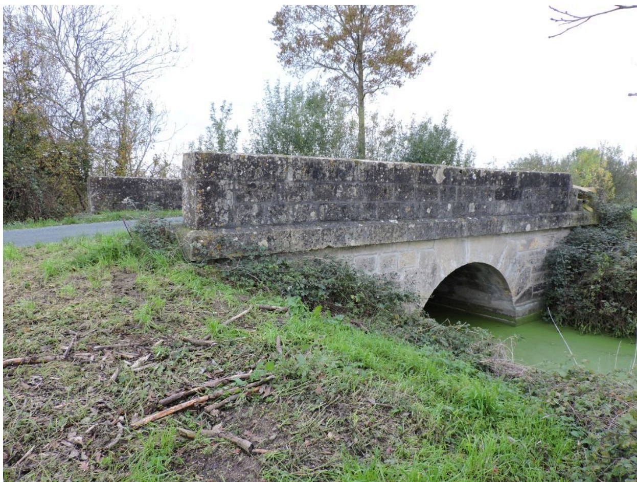
Le pont vu depuis le nord.
