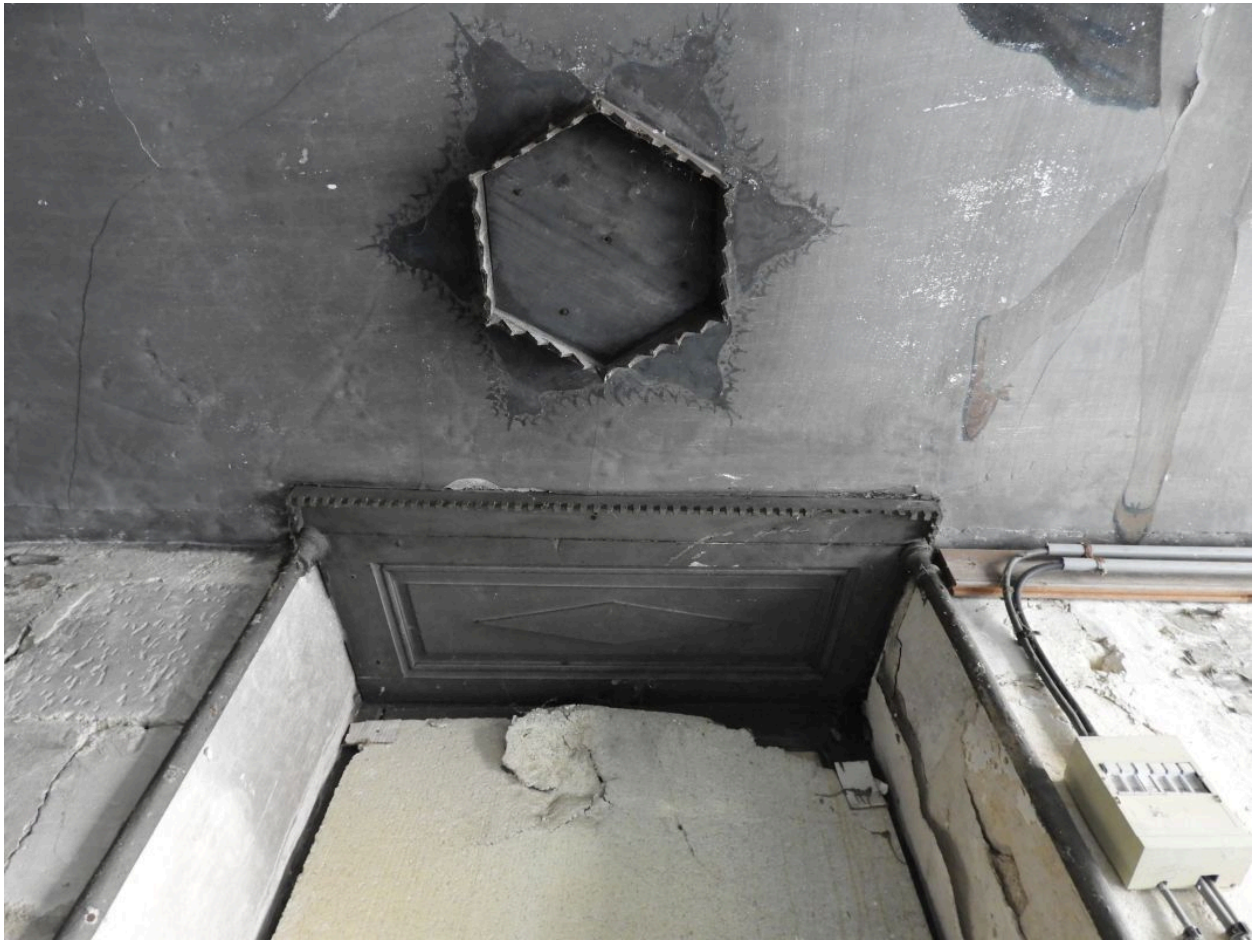
Décor peint et mouluré autour d'une baie au rez-de-chaussée.
