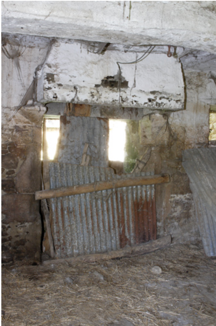
Bâtiment est. Métairie (?). Vue de la cheminée.
