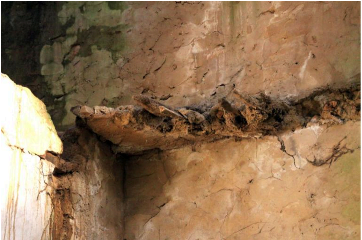
Maison 1 : traces du sol de l'étage.
