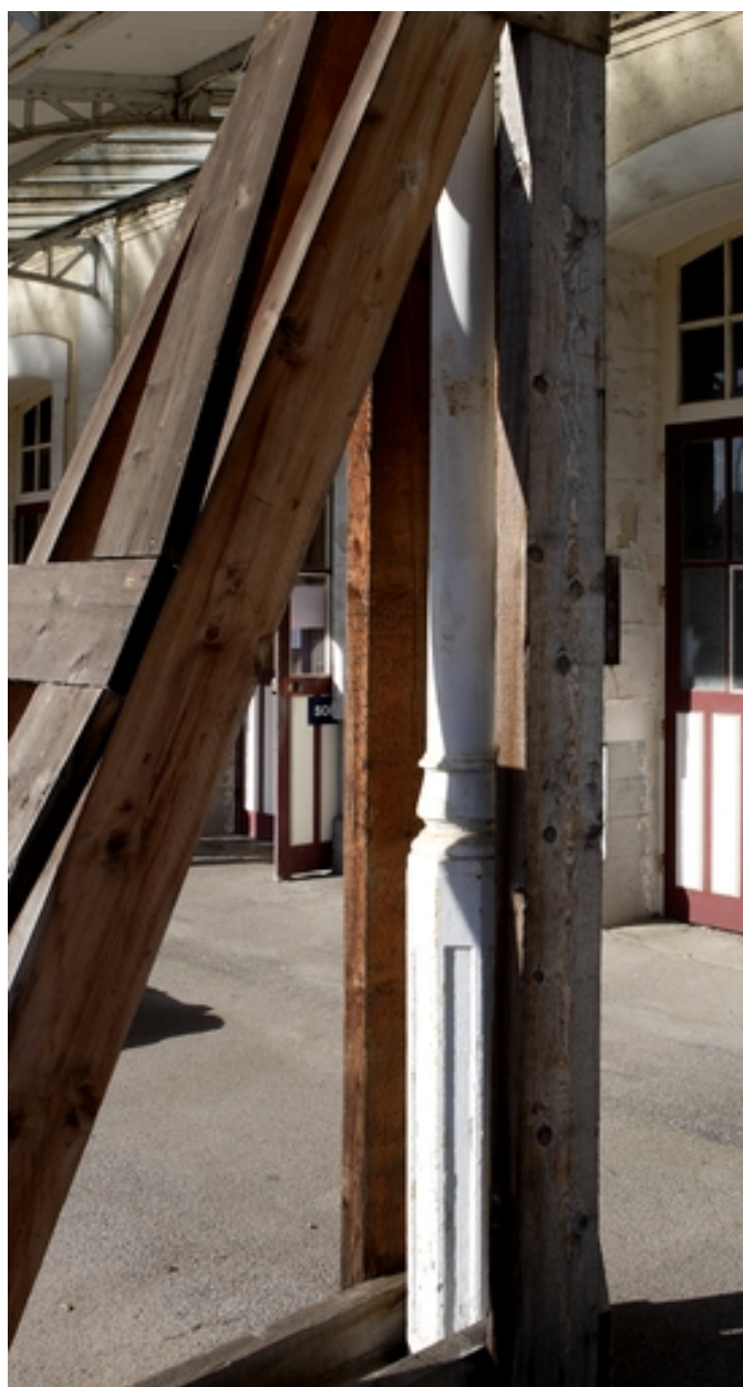
Poteau-gouttière soutenant la marquise.
