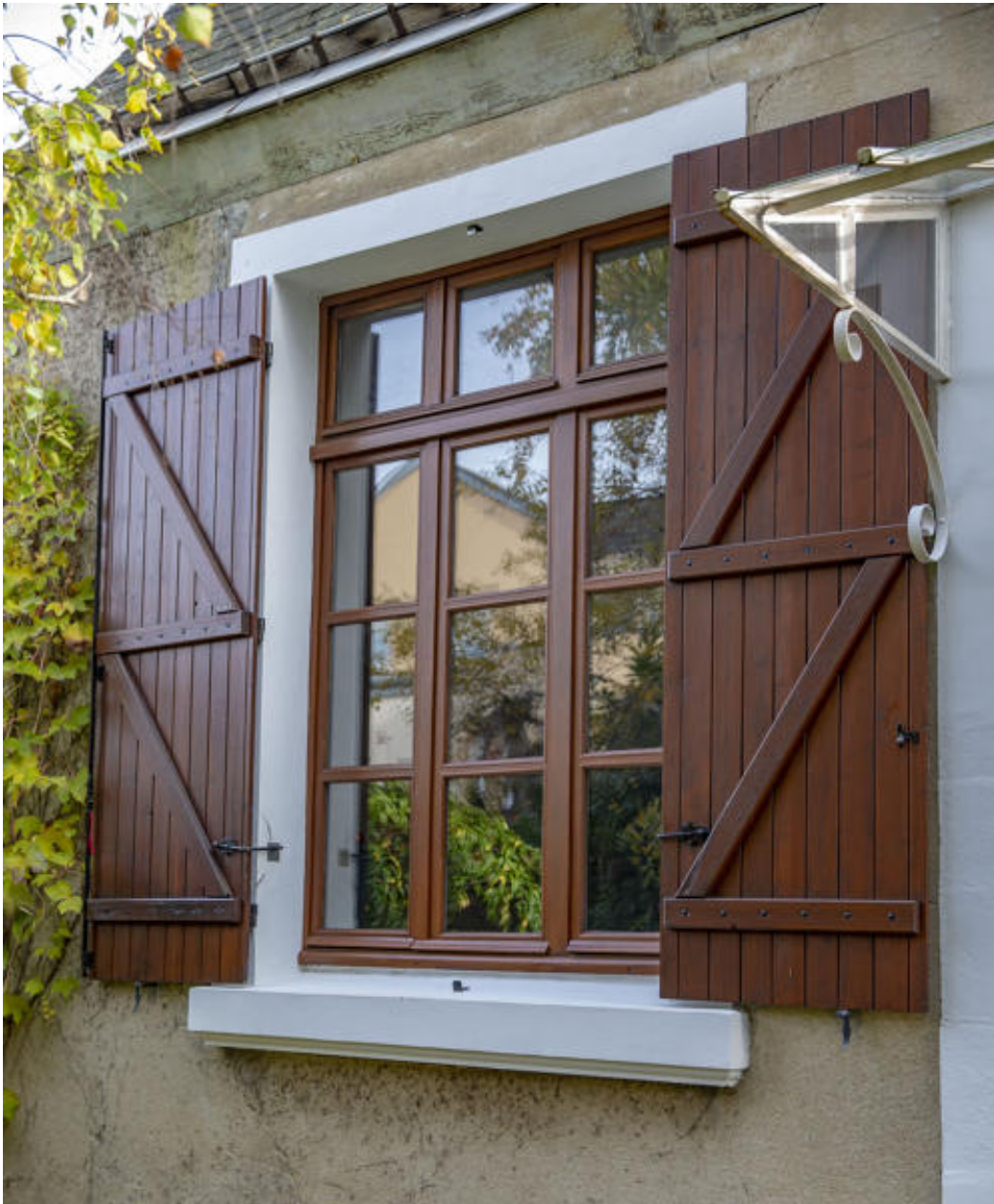
Vue d'une fenêtre d'origine sur la façade principale.
