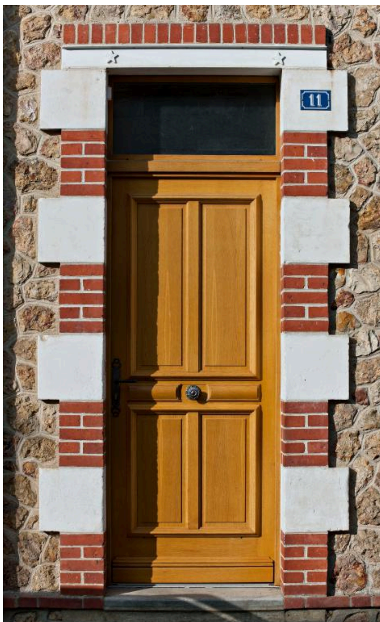
Détail de la porte d'entrée.
