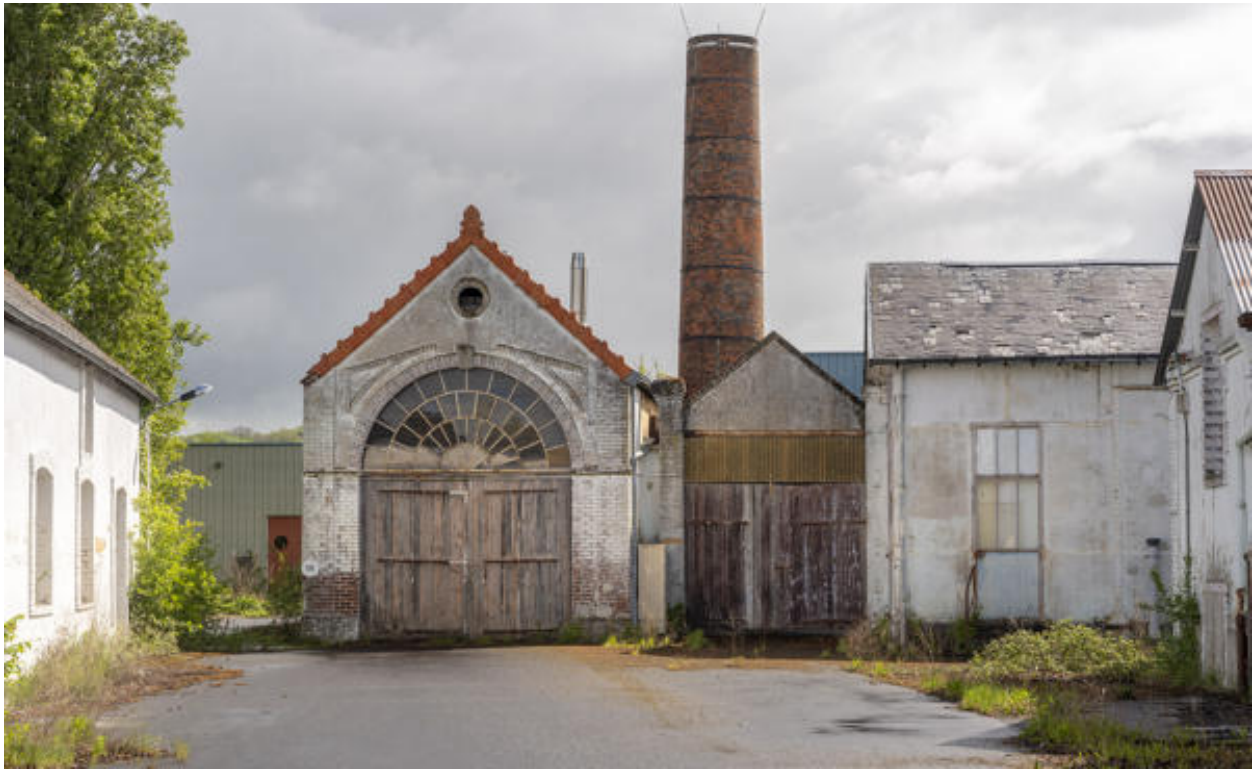
Vue d'ensemble de l'usine textile.
